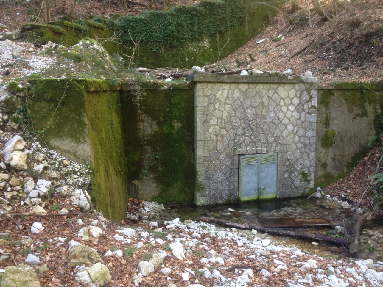
Bottino di presa in località "Troncone":
