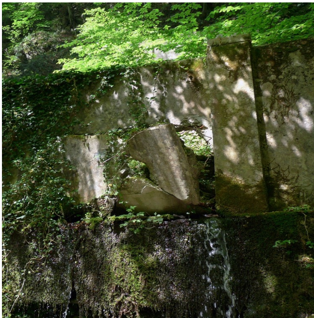
Particolare delle mura di recinzione che circondano i bottini di presa in località “Vallone Della Neve”
