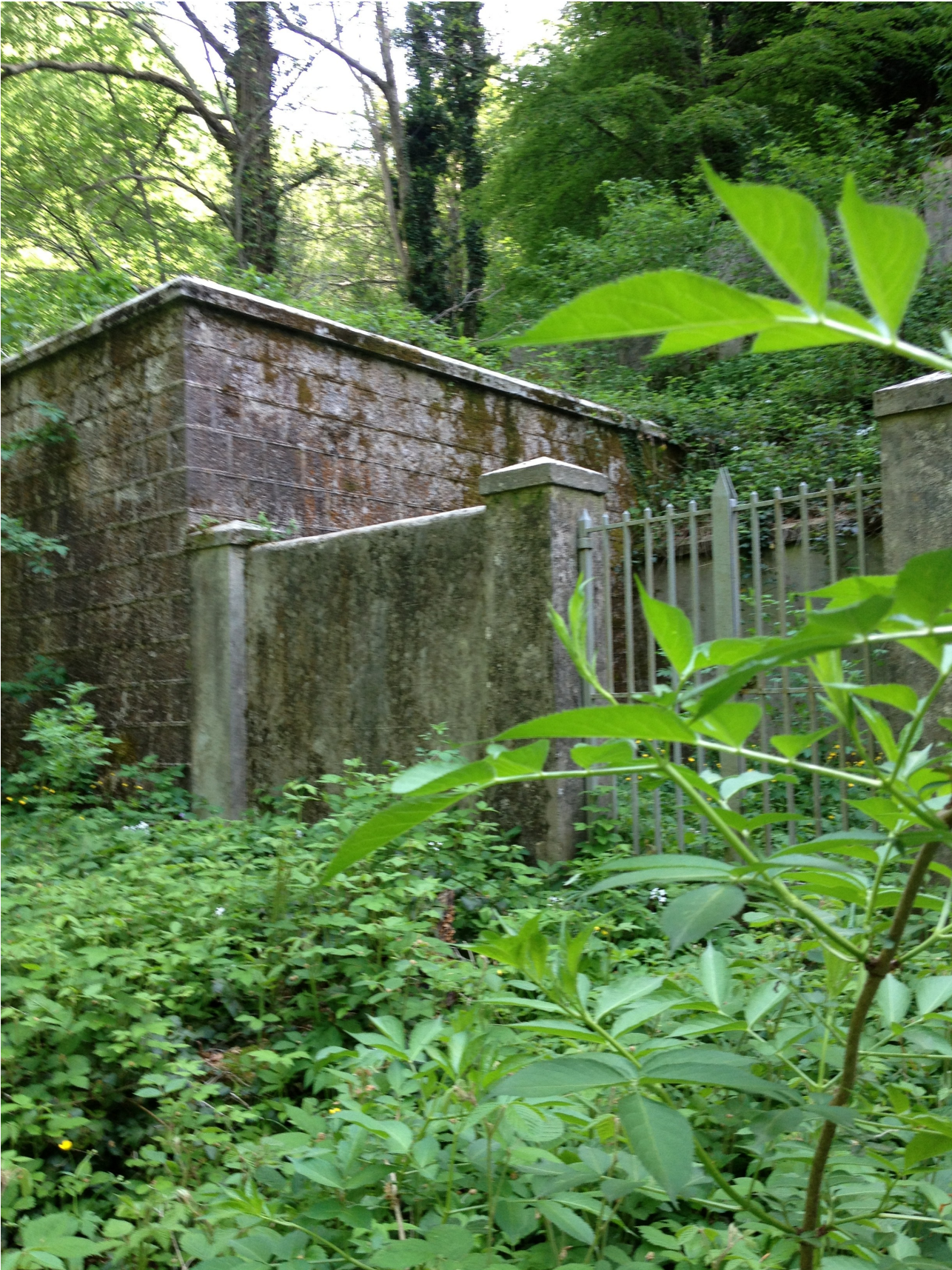
Bottino di presa in località "Savina Bassa", completamente circondato dalla fitta vegetazione:
